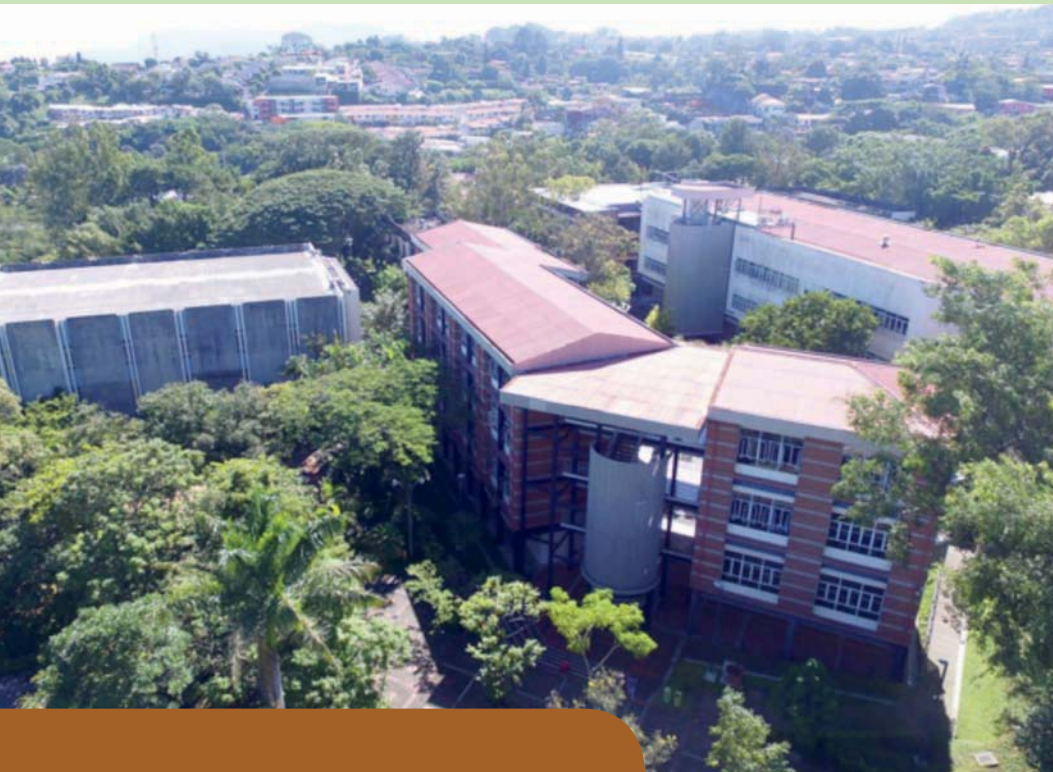
Edificios "D", Biblioteca Florentino Idoate S.J. y Jon de Cortina , S.J.
